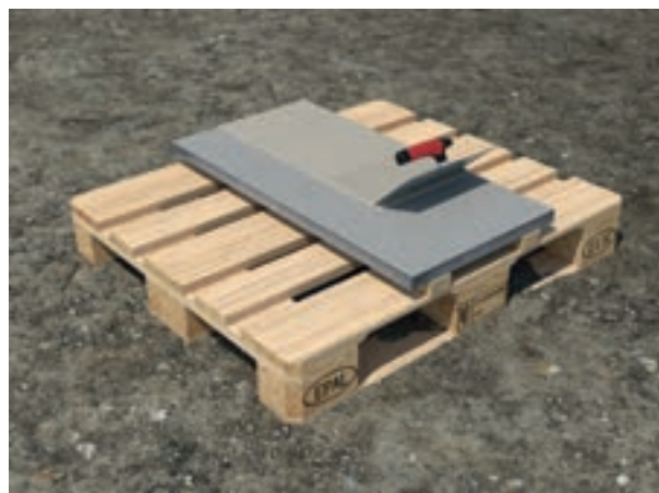
Abbildung 5: Richtiges Patschokieren
