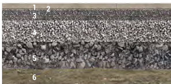
Abbildung 4: Aufbau gebundene Bauweise (Oberbau 1–5)
