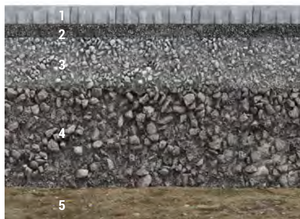
Abbildung 3: Aufbau ungebundene Bauweise (Oberbau 1–4)
