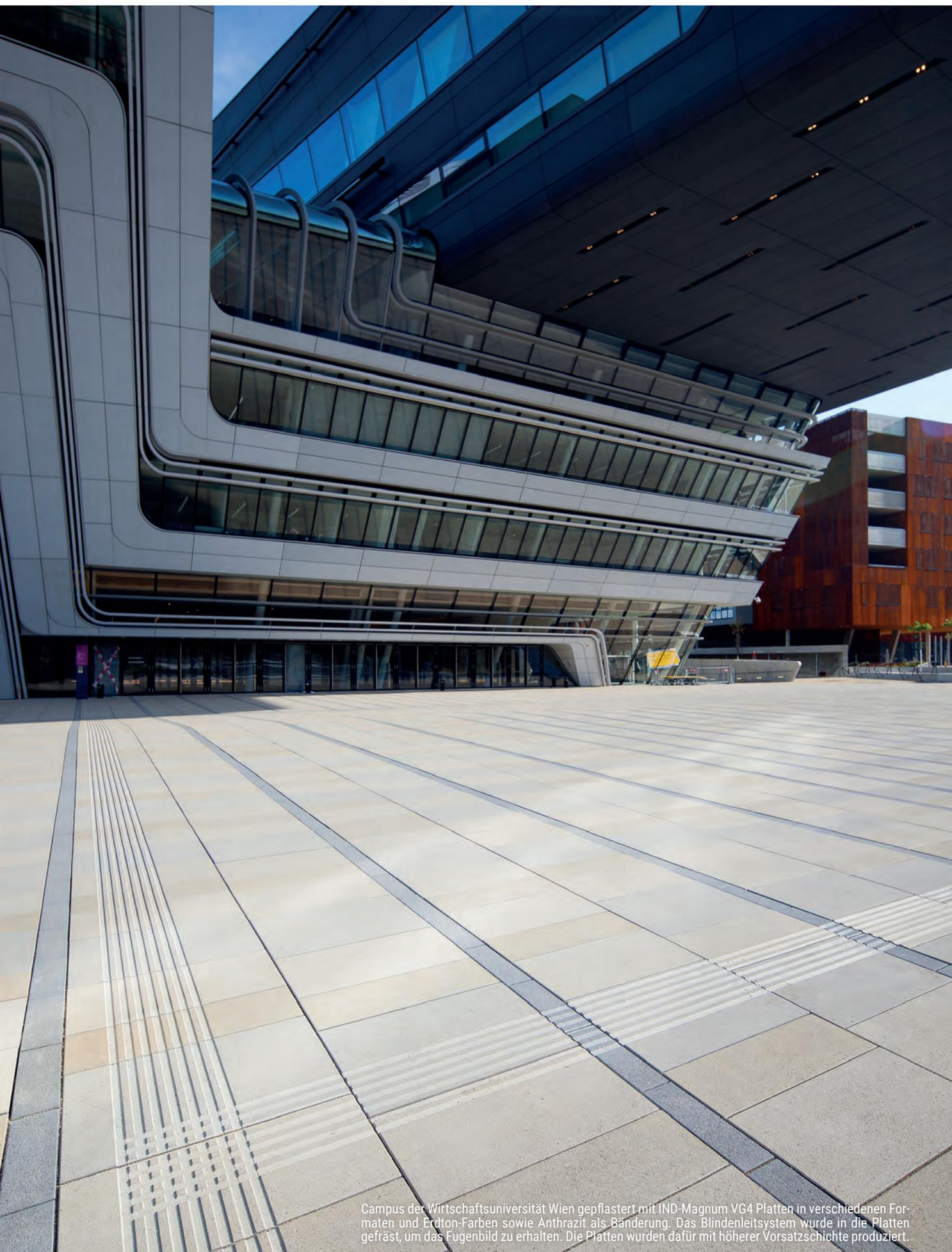
Campus der Wirtschaftsuniversität Wien gepflastert mit IND-Magnum VG4 Platten in verschiedenen Formaten und Erdton-Farben sowie Anthrazit als Bänderung. Das Blindenleitsystem wurde in die Platten gefräst, um das Fugenbild zu erhalten. Die Platten wurden dafür mit höherer Vorsatzschicht produziert.
