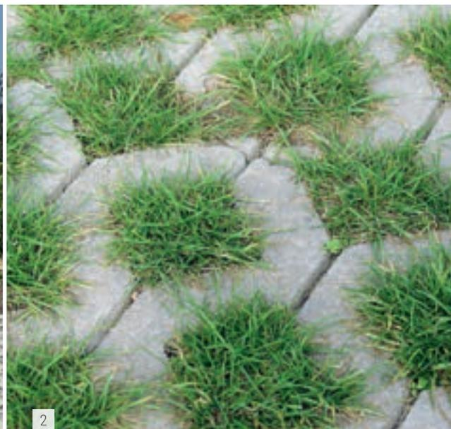
Platten, die eine Versickerung von Regenwasser begünstigen und begrünbar sind: die grauen RASENGITTER QUADRO und ROMBO. Der MARKIERUNGSSTEIN dient insbesondere in den Farben Anthrazit und Ziegelrot der optischen Trennung von Parkplätzen.
