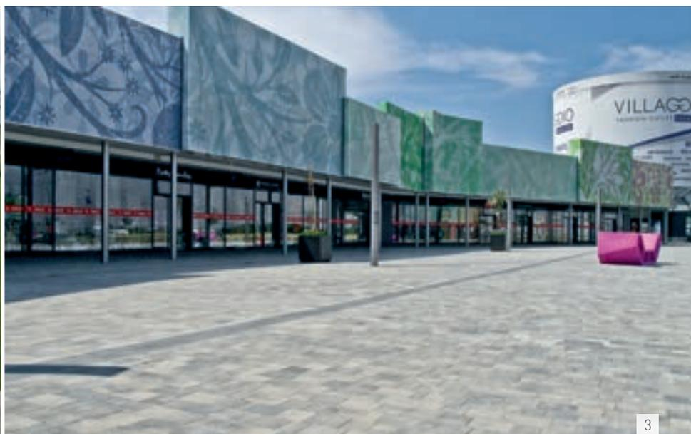
Der PIAZZA ist scharfkantig und wird unregelmäßig in Bahnen verlegt. Mit seinen sieben verschiedenen Formaten – einer Länge von 10 bis 22 cm und einer Breite von 16 cm – können kleine sowie große Flächen sehr attraktiv gestaltet werden.
