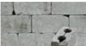
**Verlegen Sie auch Steine mit stärker oder unregelmäßig gealterten Kanten und Ecken. Dieses antike Aussehen ist erwünscht und macht bei richtiger Verlegung und Verfugung den Reiz der antiken Fläche oder Mauer aus.**
