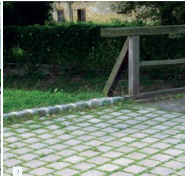
Die Sickersteine VERDE und ÖKO PLUS eignen sich perfekt für die Befestigung von Flächen ohne diese zu versiegeln. Abstandsnoppen gewährleisten das Absickern von Wasser. Mit Pflanzsubstrat befüllt und besät, erhält die mit Verde gepflasterte Fläche einen grünen Touch.
